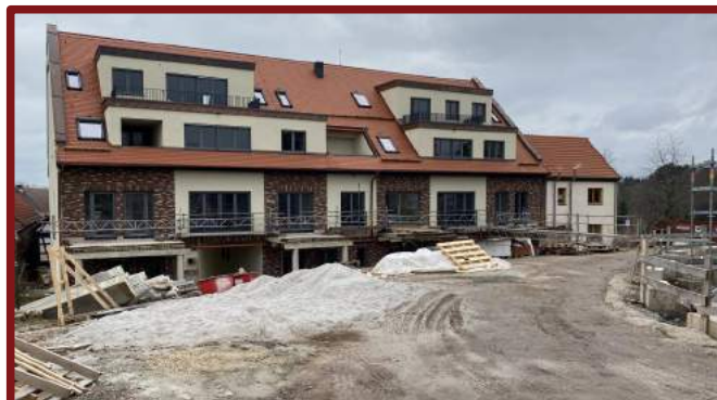
Baustelle Ende März
